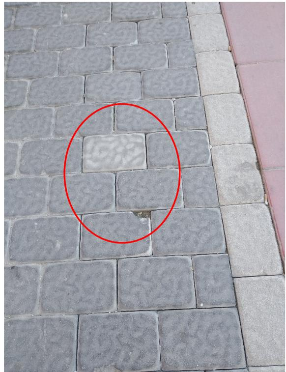
2.- Tramo de la calle Mar Menor entre Calle Fabricas y Antonio Machado con losa deteriorada junto a la traza de la zanja realizada.
